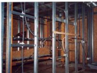
Utilizando os orifícios próprios dos perfis, a canalização e tubagem eléctrica é disposta nas paredes deixando os terminais nos locais previamente escolhidos. Todo este processo é executado com enorme facilidade, uma vez que não temos que abrir roços e as paredes ainda não se encontram revestidas.
