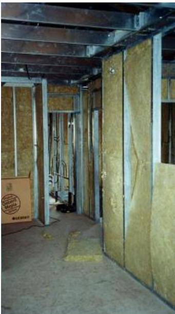
Seguidamente procede-se ao revestimento das paredes interiores com lã de rocha. Este material é formado por fibras minerais de rocha vulcânica, apresentado em forma de placa ou manta, inserido no espaçamento entre vigas ou perfis metálicos, sendo totalmente imune à acção do fogo e com excelentes propriedades de isolamento térmico e acústico. Não provoca alergias, não absorve água, não apodrece, permite a passagem do ar e tem durabilidade ilimitada.
