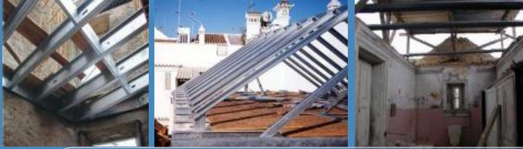
O novo projecto de estabilidade e execução irá consagrar estes apoios e dentro deste atravancamento irá ser fixada toda a estrutura metálica que, além de criar novos espaços habitacionais, agarra e consolida a antiga estrutura.
