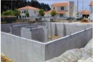
◀ A ancoragem é feita sobre laje tradicional, com ou sem cave, através de buchas químicas de total resistência anti-sísmica.
